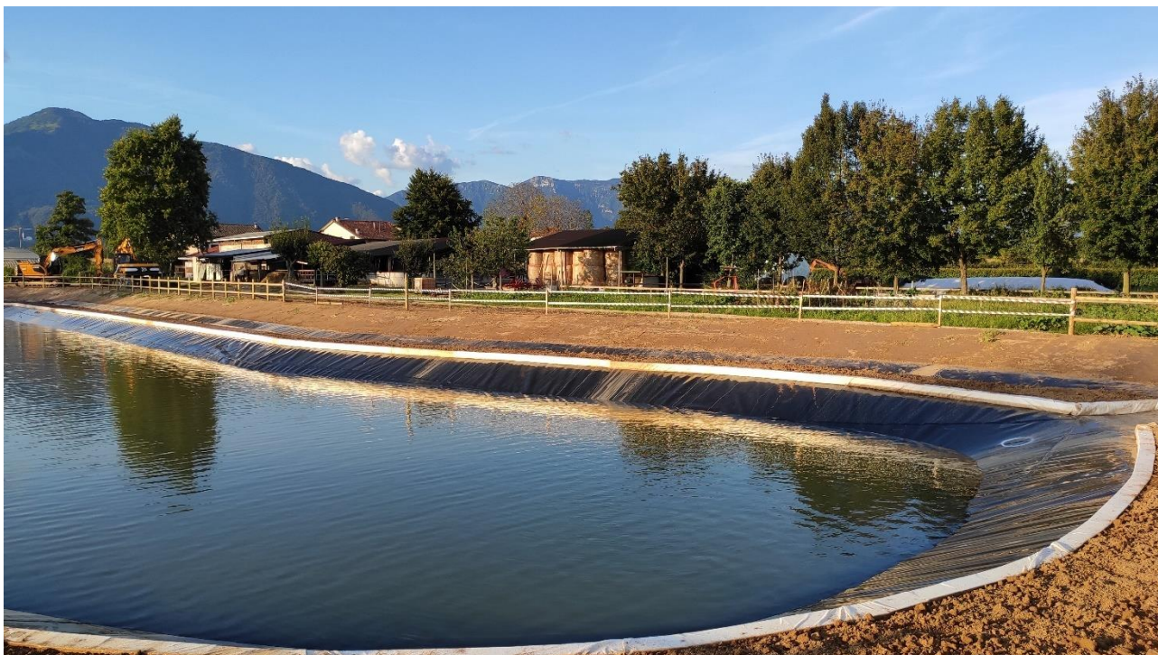
Fig.2 Bacino a lavori finiti, prima delle piantumazioni e semine.
