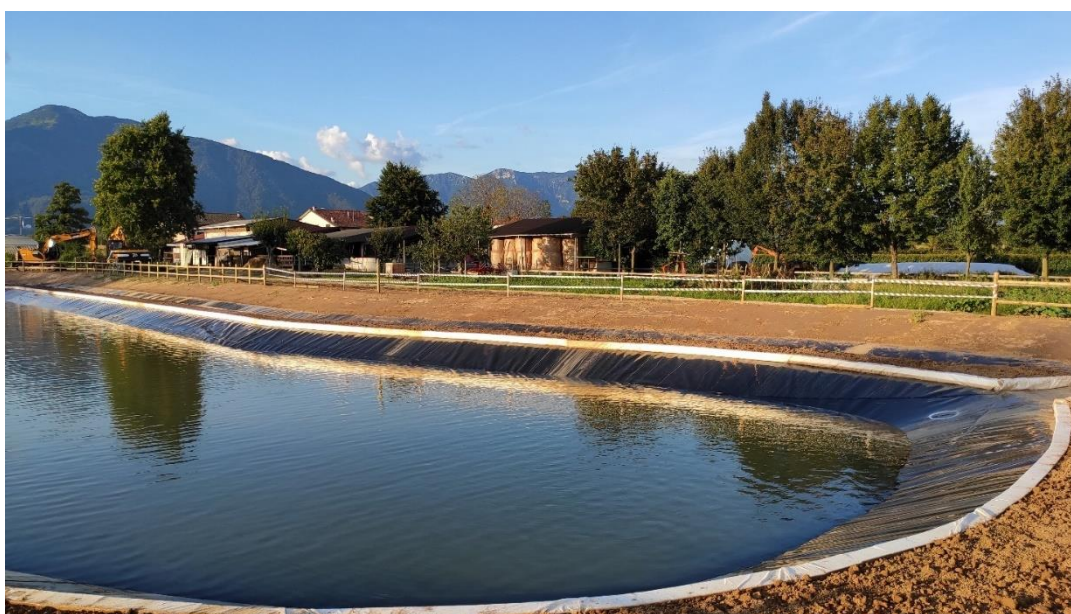
Figura 3 Bacino a lavori finiti, prima delle piantumazioni e semine.
