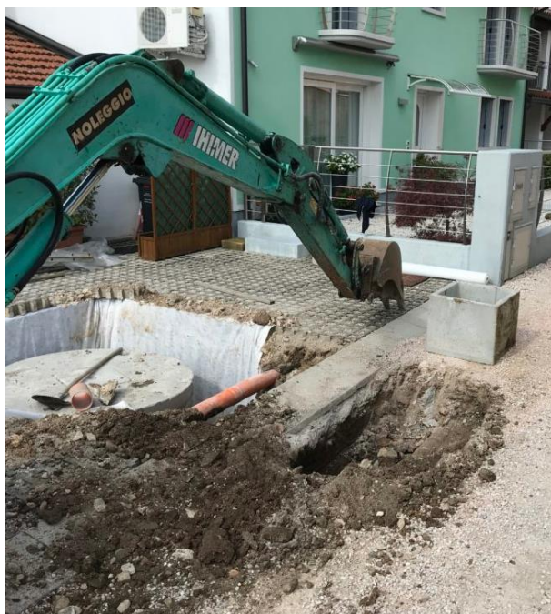
Figura 4. Fase di realizzazione del pozzo perdente di Corte Acquasaliente (Santorso, VI) realizzato nell'ambito del progetto BEWARE. Si osserva la camera in calcestruzzo con chiusino per l'ispezione, e la posa del geotessuto di separazione posizionato tra il terreno naturale e lo strato di materiale drenante.
