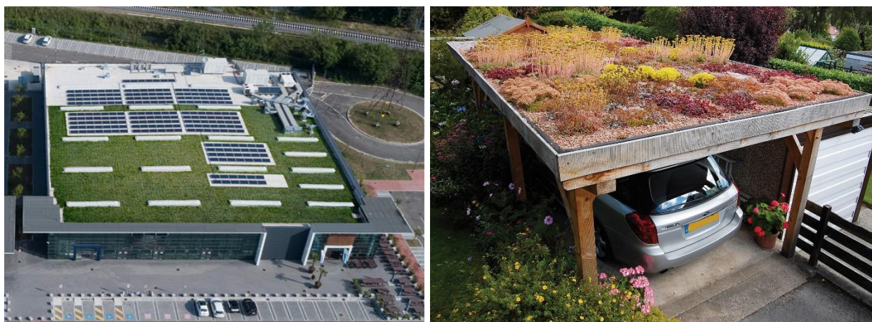
Figura 3. Foto di un tetto verde estensivo realizzato sulla copertura di un supermercato (a sinistra) e su una tettoia per il posteggio dell'auto (a destra).
