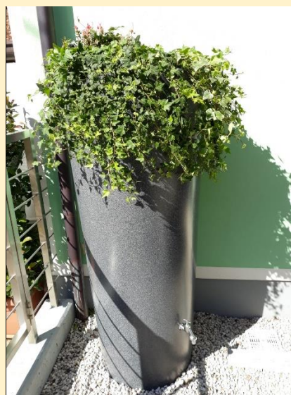
Figura 2. Esempi di serbatoi fuori terra: a sinistra un tipico esempio di serbatoio a capienza elevata (tipicamente tra 500 e 10000 l), mentre a destra uno dei serbatoi installati a Santorso nell'ambito del progetto BEWARE (esempio di serbatoio di piccole dimensioni, ma di maggior valore estetico).
