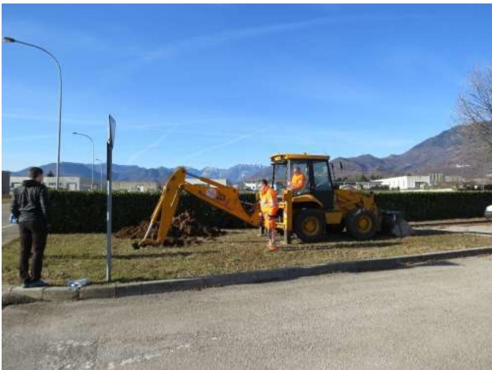
*Figura 7.11. Inizio lavori di scavo per l'identificazione del profilo pedologico prima dell'intervento, sull'aiuola O su cui verrà costruito uno dei due rain garden.*
