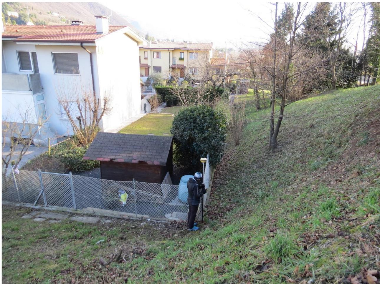
*Figura 8.7. Versante nord della Collina del Grumo a ridosso della proprietà privata più a sud di via De Gasperi; in questa zona verrà realizzata la fascinata viva al fine di migliorare la condizione di stabilità del versante.*
