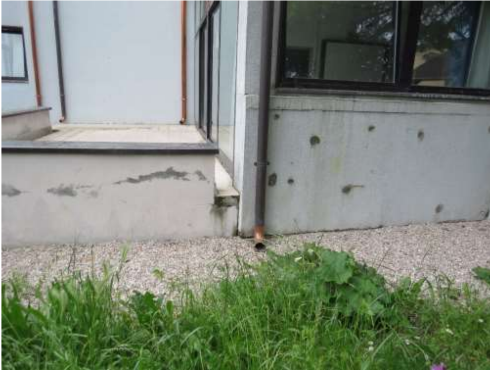
Figura 7.12. Grondaia localizzata nel lato S del muro delle scuole medie, sprovvista del sottostante pozzetto. Da progetto è previsto l'inserimento della fioriera al di sotto di questa grondaia.
