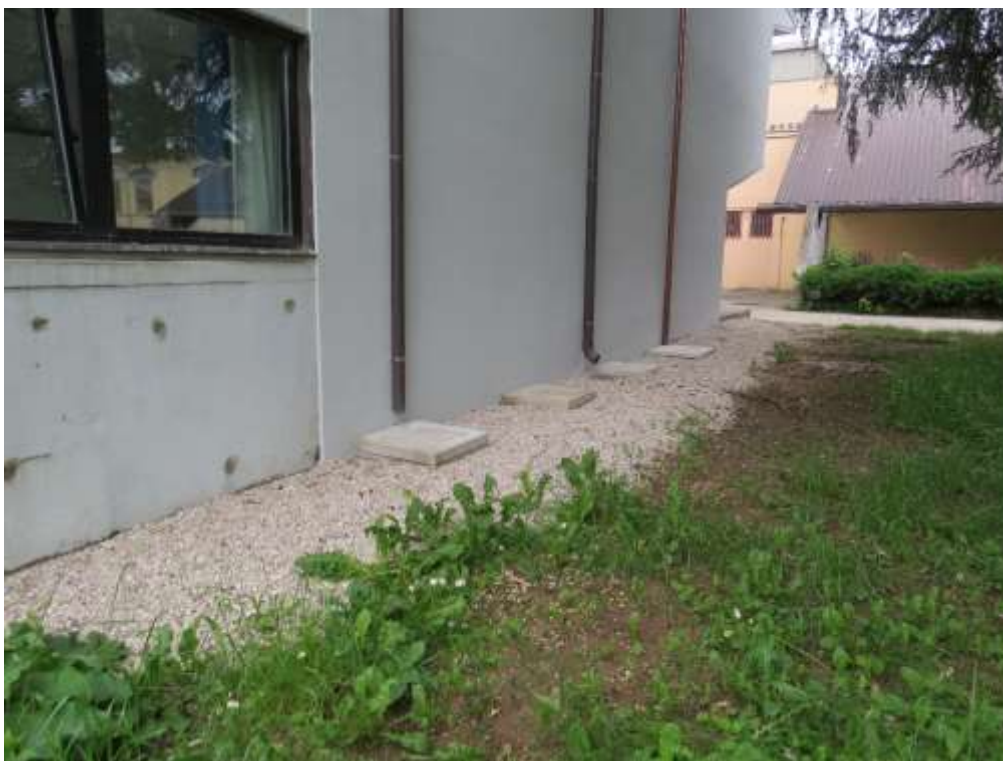
Figura 7.11. Grondaie con sottostanti pozzetti perdenti, posizionate sul muro esterno delle scuole medie, lato S (verso il nuovo RG-SM).
