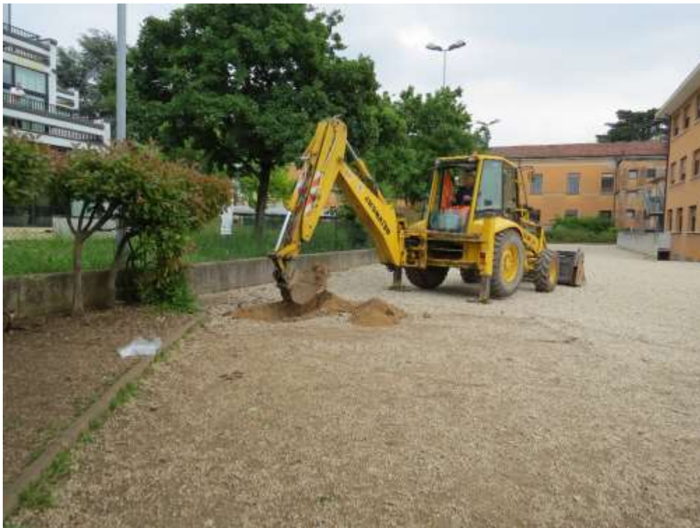
Figura 7.15. Inizio lavori di scavo per l'identificazione del profilo pedologico nell'area del RG-SE.
