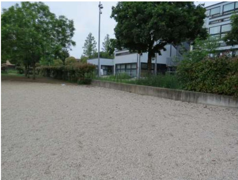
Figura 7.6. Zona del piazzale in ghiaia su cui verrà scavato il RG-SE (adiacente al muretto). Nel muretto divisorio tra le due scuole verrà inoltre fatto passare il tubo di troppo pieno che permetterà il deflusso dei volumi idrici in eccesso proveniente dal RG-SM.
