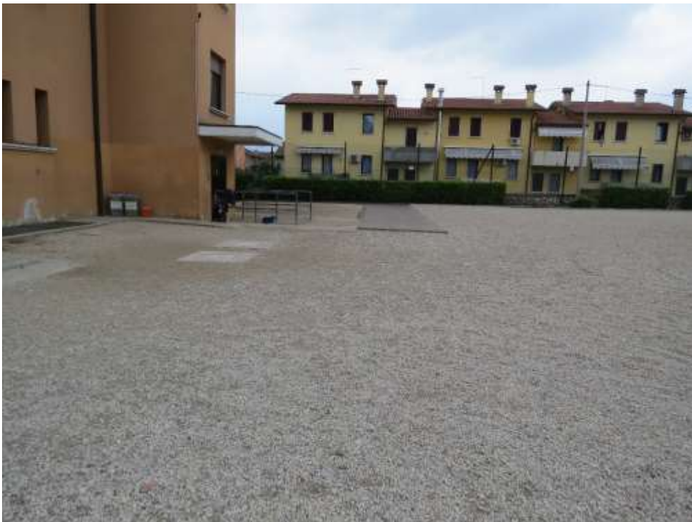
Figura 7.5. Vista in direzione O della pavimentazione attualmente presente da cui proseguirà la posa dei masselli Recycle.
