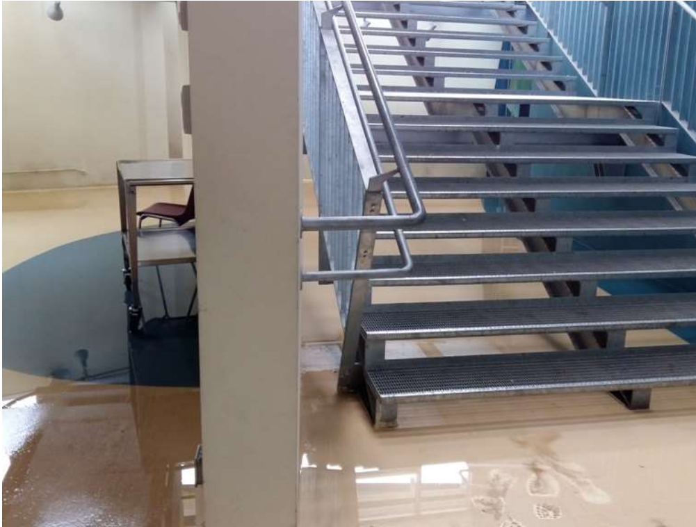
Figura 7.2: Altra documentazione dell'allagamento subito dal piano interrato delle scuole elementari nel maggio 2017.
