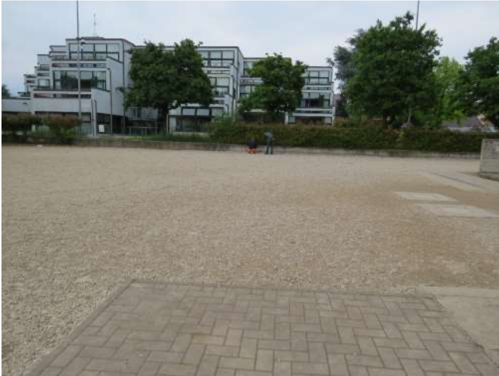
Figura 7.4. Vista verso la scuola media, dal piazzale in ghiaia sul retro della scuola elementare. Nel punto in cui si trovano i due operatori è previsto lo scavo del RG-SE, mentre la posa della pavimentazione Recycle proseguirà dalla pavimentazione attualmente già presente, visibile in primo piano in basso.
