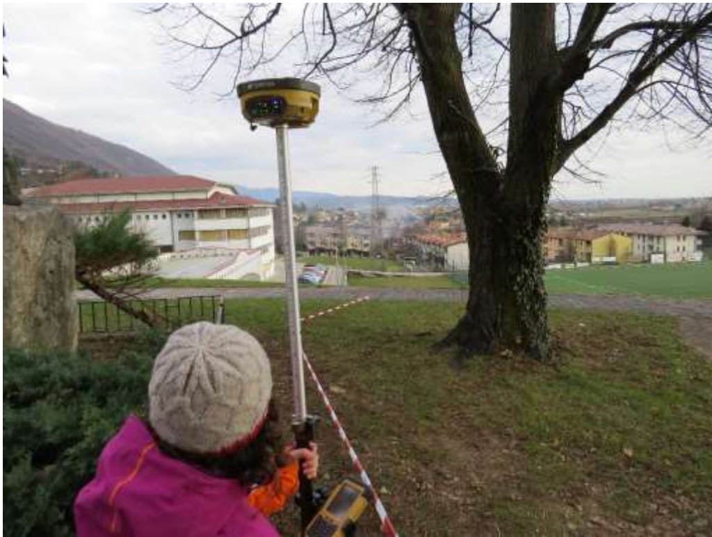
Figura 7.12. Raccolta dei punti GPS (Topcon Hyper V) per la progettazione del tubo in uscita dal rain garden.
