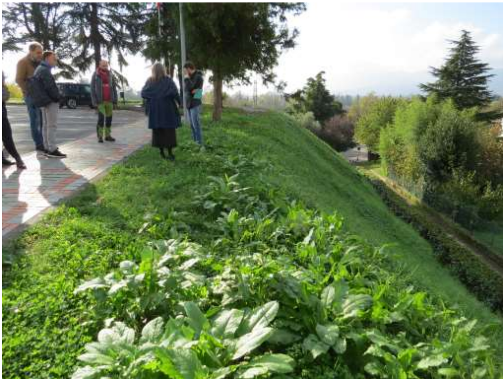
Figura 7.7. Scarpata consolidata ed inerbita nella parte ovest del parcheggio della Piazza della Libertà dotata di canalette superficiali per lo smaltimento a valle dell'acqua.
