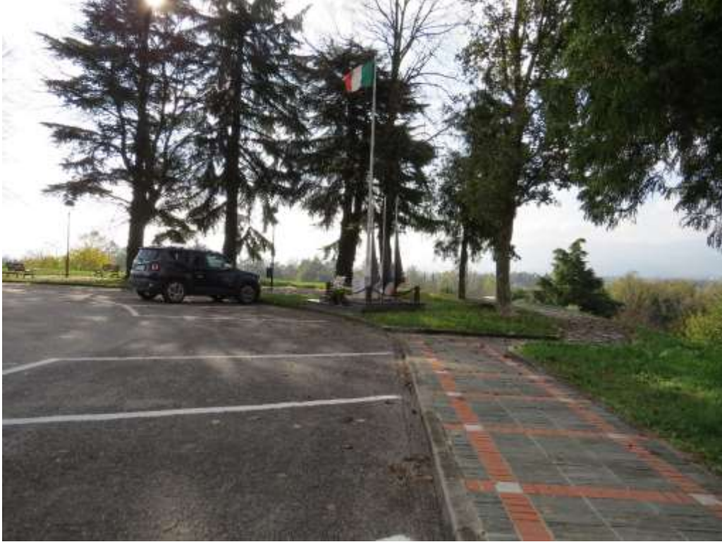
Figura 7.4. Cordolo interessato attualmente da ruscellamento durante fenomeni di pioggia intensi. Il progetto prevede la realizzazione in questo sito di una griglia di intercettazione dell'acqua che confluisca nel giardino pluviale.
