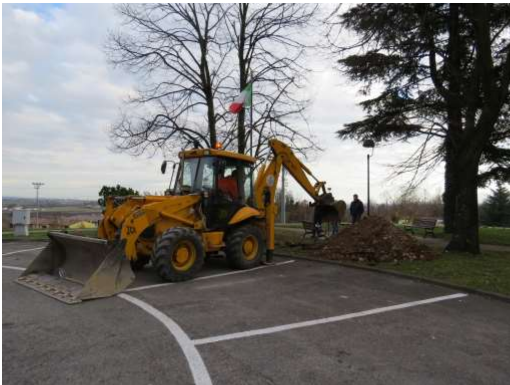
Figura 7.15. Vista posteriore dello scavo.
