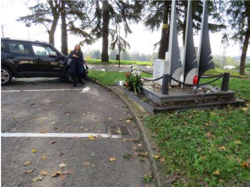
Figura 7.6. Caditoia a griglia (zona Sud attigua al cordolo) a servizio della semi-U-Ovest del settore. Questa caditoia verrà rimossa per dare spazio ad una griglia confluyente nel rain garden.
