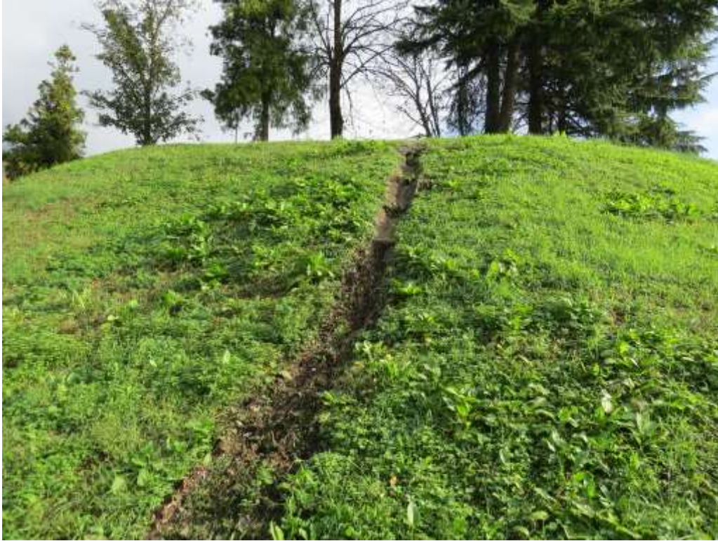
Figura 7.8. Discreta erosione della scarpata laterale Ovest del parcheggio dovuta alle abbondanti piogge in un recente evento meteorico di fine ottobre 2018.
