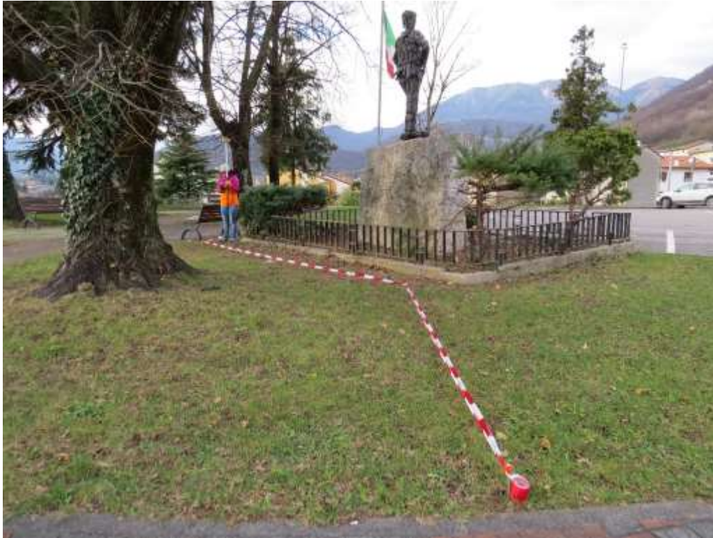
Figura 7.10. Tracciamento del tubo in PVC in uscita dal rain garden. Vista posteriore, lato Est.
