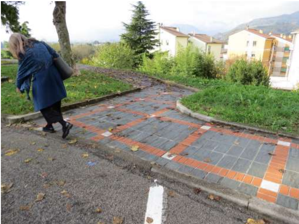
Figura 7.5. Lato Ovest del cordolo che presenta un'interruzione per agevolare una passeggiata perimetrale dentro la zona verde del parcheggio. Tale interruzione fa sì che durante le precipitazioni intense parte delle acque prodotte nella zona semi-U-Ovest non arrivino fino al cordolo lato Sud ma vengano scaricate lungo la scarpata laterale.
