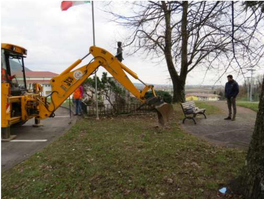
Figura 7.14. Inizio lavori di scavo per l'identificazione del profilo pedologico prima dell'intervento.
